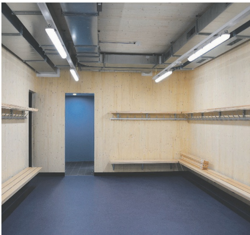
Deutlich grössere Garderoben, die Wände sind aus Fichtentäfern, der Boden ist in Blau gehalten.
